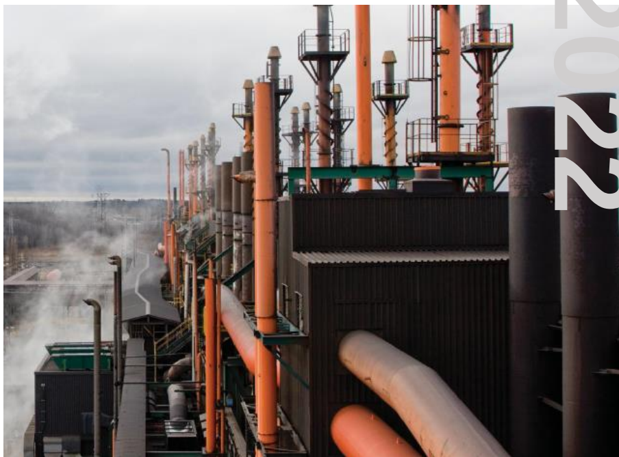
Vue depuis le toit de l'Usine de réduction, RTFT
