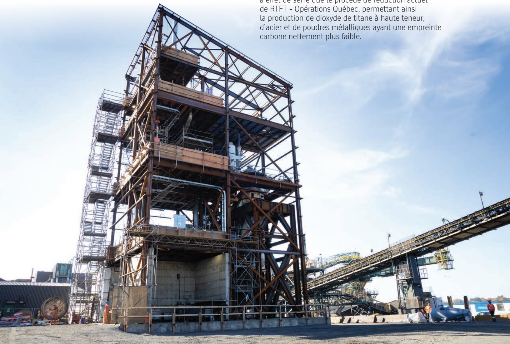
L'Usine BlueSmelting en construction.
