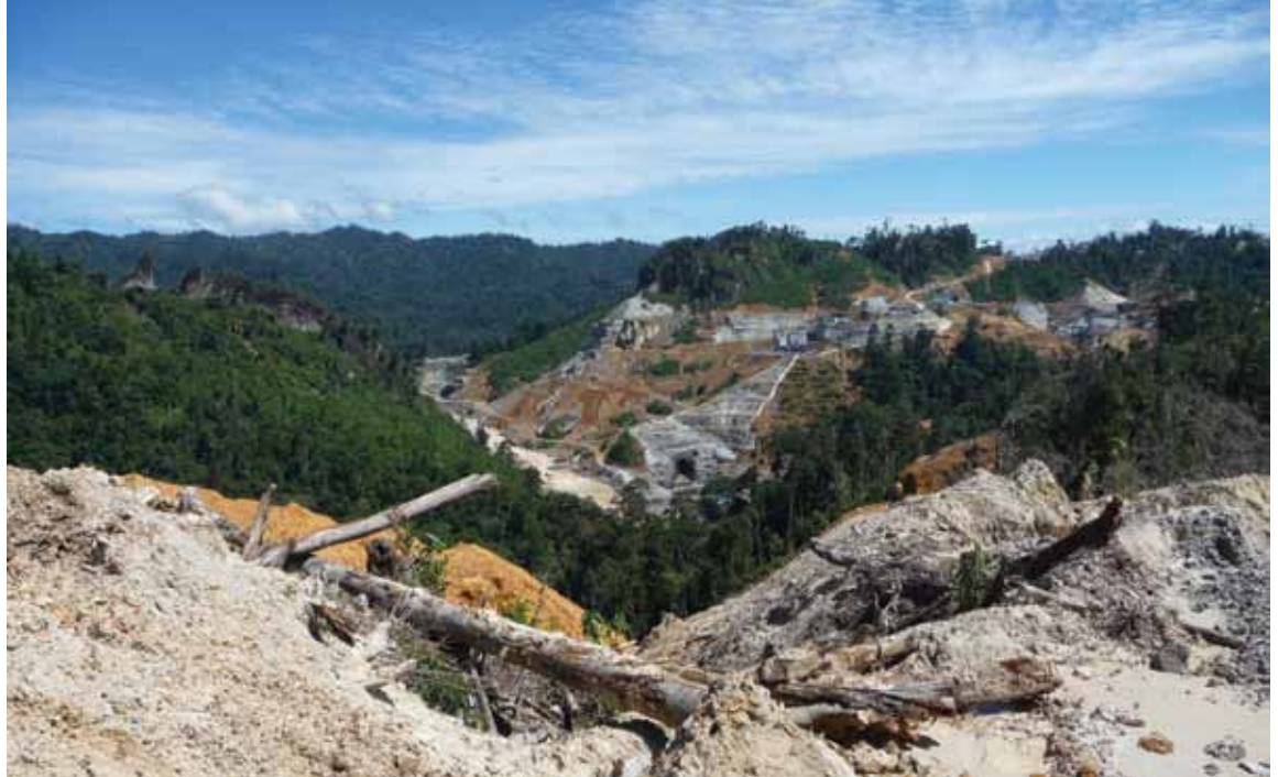
Tierra despejada cerca de la represa de Murum en Sarawak, Malasia.
